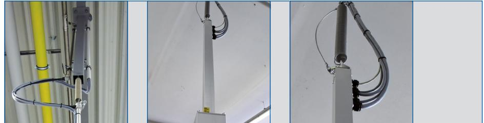
Die E-BOX wird mit einem speziellen Befestigungsset an der Hallendecke oder an einem bauseitig angebrachten Profil befestigt.
